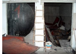
Die Erdöltanks in der 1. Etappe werden herausgeschweisst
