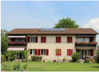
Sonnenkollektoren in der 1. Etappe für die Warmwasseraufbereitung
