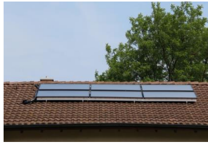
Sonnenkollektoren in der 1. Etappe für die Warmwasseraufbereitung
