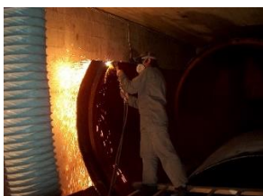
Die Erdöltanks in der 1. Etappe werden herausgeschweisst
